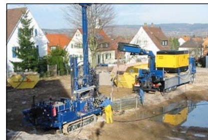
Erdsondenbohrung für das Patio-Wohngebäude
