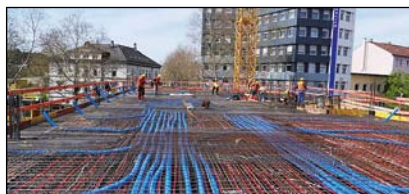
Betonkerntemperierung mit eingelegten Lüftungsleitungen
